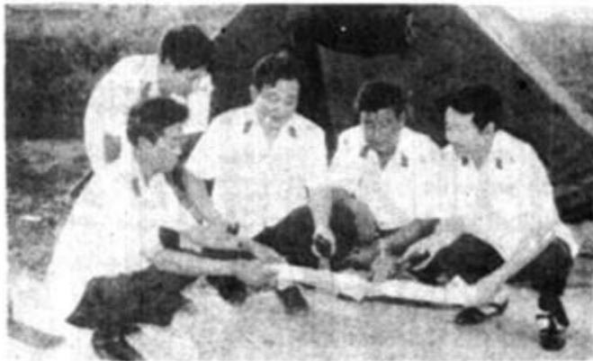
图为局党组一班人正在施工现场研究工作。
